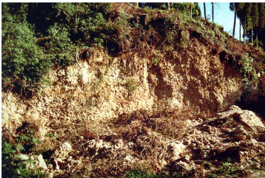
Foto 42 - La scarpata nei ciottolami di Fabbrica, modificata da una frana recente.
